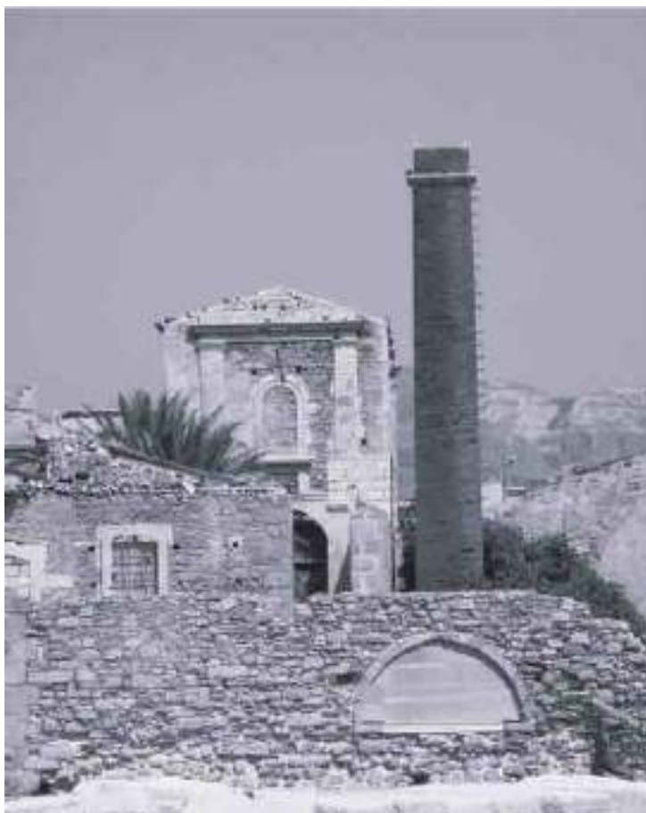
Figura 3. Veduta della chiesa con accanto la ciminiera in laterizio [Fonte: Lippi Guidi, 1993].
