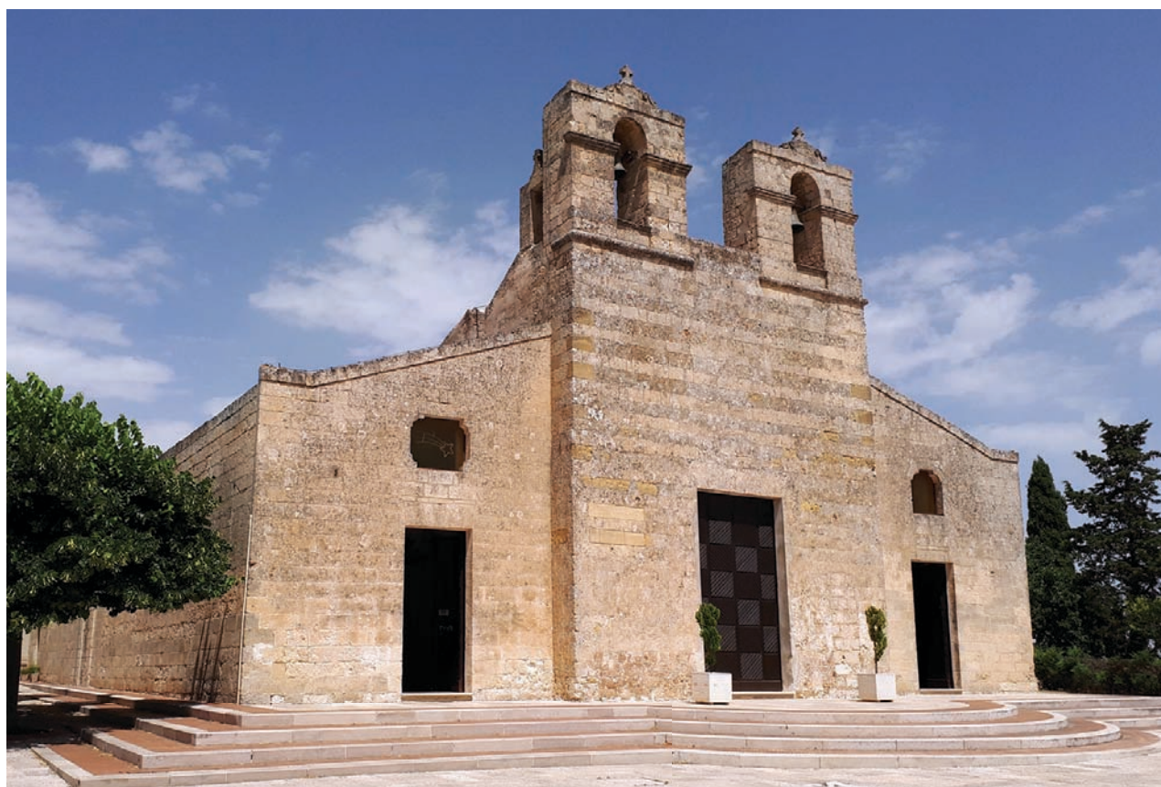
Fig. 1 - Facciata principale dopo l'inversione dell'orientamento
