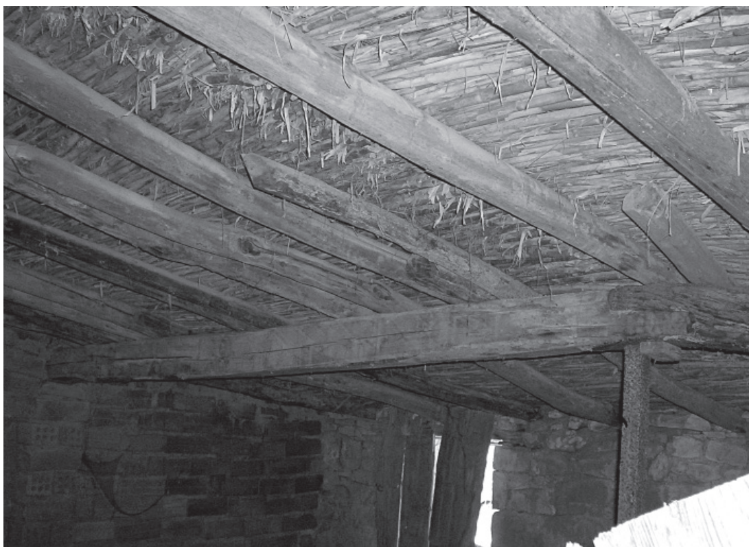
Fig. 2 - Interno con tetto a falda unica a Aghios Alèxandros (C. Piccoli)
