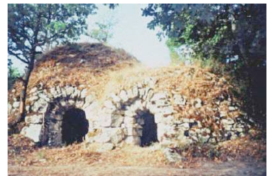
Fig.7 - Pagliari di Acerenza. Source: Le capanne in pietra a secco con cupola in aggetto d'Italia, Marco Miosi, 2013
