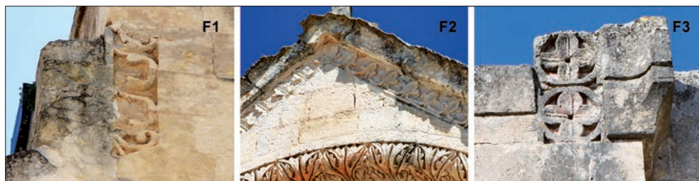
Fig. 3. - Matera, chiesa di Santa Maria la Nova: resti dei fregi sommitali. F1: fregio a gigli pervenuto solo in lacerto sulla facciata W; F2: fregio a gigli che segue la sagoma della testata del transetto S; F3: tracce di mastiche rosso sugli unici due conci rimanenti del fregio sommitale a rose quadripetale, situati nei pressi dell'attacco della navata centrale con il fronte absidale (foto S. Centonze - 2022).
