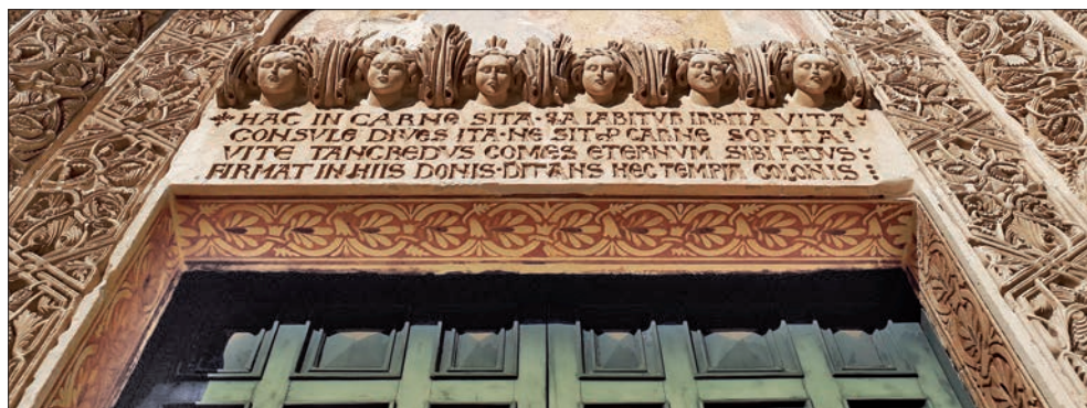
Fig. 4. - Lecce, chiesa dei SS. Nicolò e Cataldo: particolare del portale principale. Il decoro a girali incrostato di mastice rosso e nero segue l'intradosso in modo continuo dai piedritti all'architrave, che sono ricavati da tre monoliti unici (foto S. Centonze - 2022).
