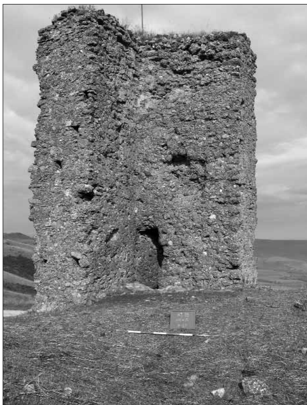
Fig. 7. - Altojanni, area A. Insediamento fortificato medievale: CF 1, la struttura ad "L" vista da sud, all'inizio delle indagini.
