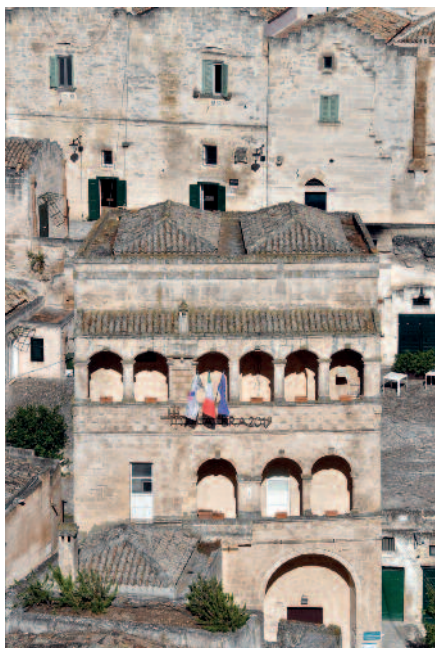
Fig. 3 - Matera, palazzo del Casale nel Sasso Barisano, ora sede della Fondazione Matera Basilicata 2019: particolare delle logge riaperte in accordo con la tipologia dell'edificio (foto di Roberto Nadalin).
