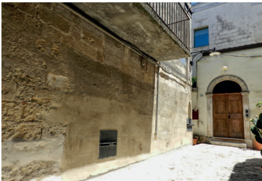
Fig. 7 - Matera, Civita: particolare della reintegrazione muraria con conci squadrate di calcarenite (foto di Roberto Nadalin).
