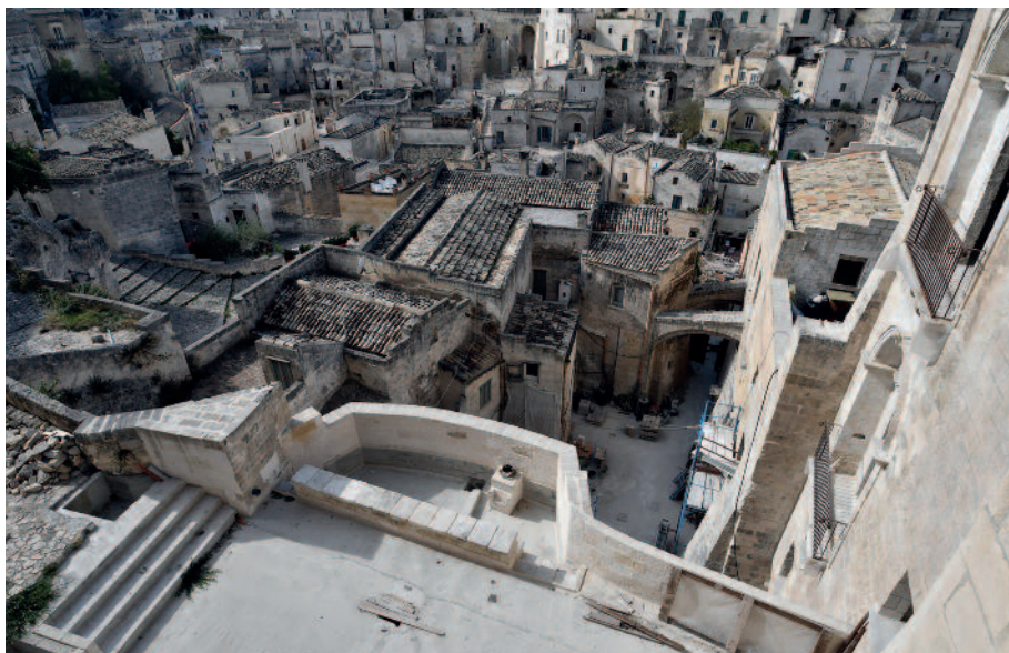
Fig. 8 - Matera, Sasso Barisano: particolare dell'alto massetto in calcestruzzo della nuova pavimentazione pubblica (foto di Roberto Nadalin).
