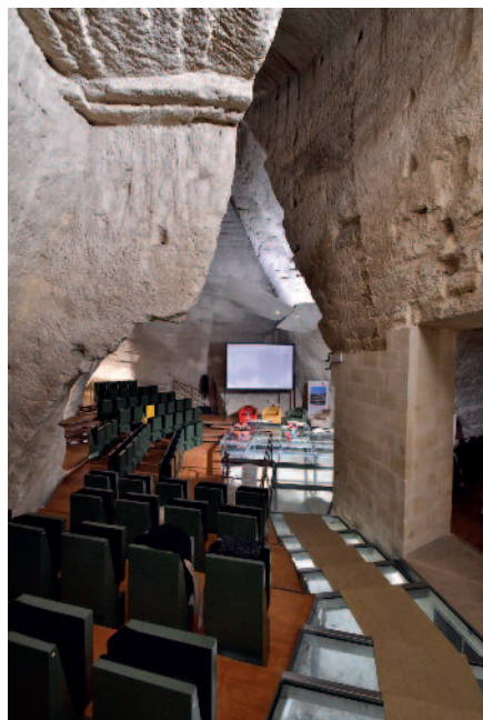
Fig. 4 - Matera, casa Cava nel Sasso Barisano: particolare del pavimento galleggiante ligneo con inserti vetrati per segnalare il percorso verso l'auditorium e l'area del palco (foto di Roberto Nadalin).
