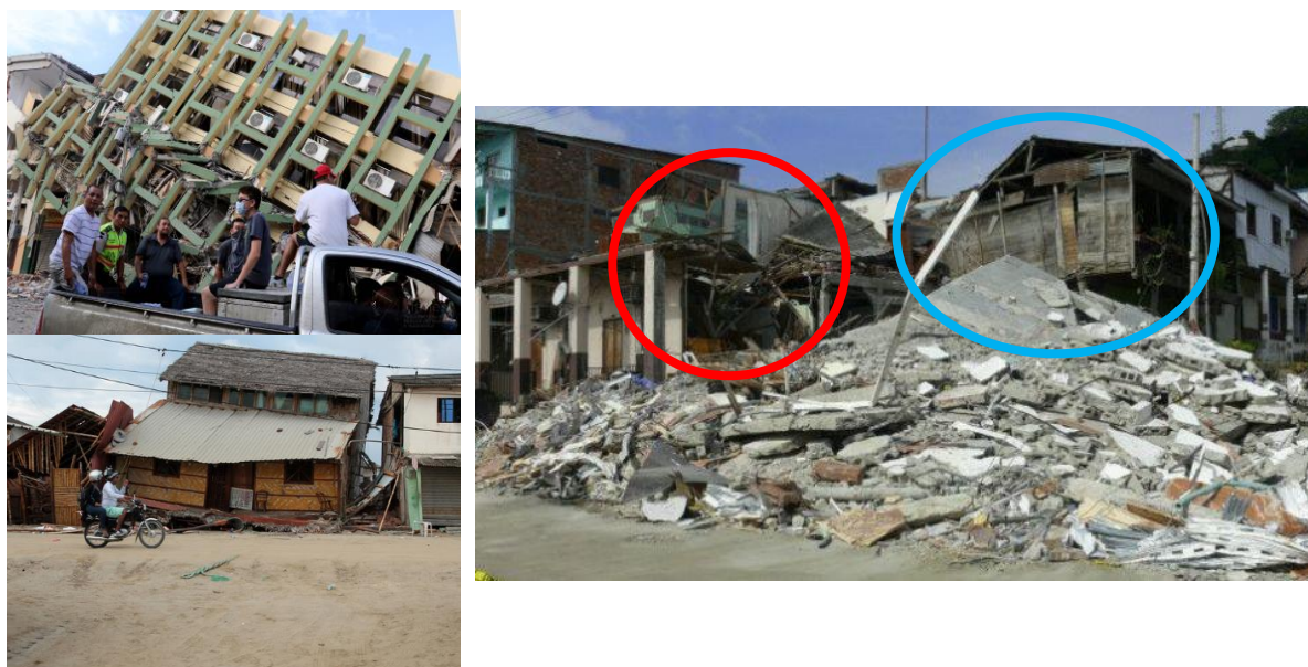
Figura 118 Demostración de desplazamiento de viviendas de caña vs viviendas de hormigón durante el terremoto. Fuente: (Diario el Universo, 2016)
