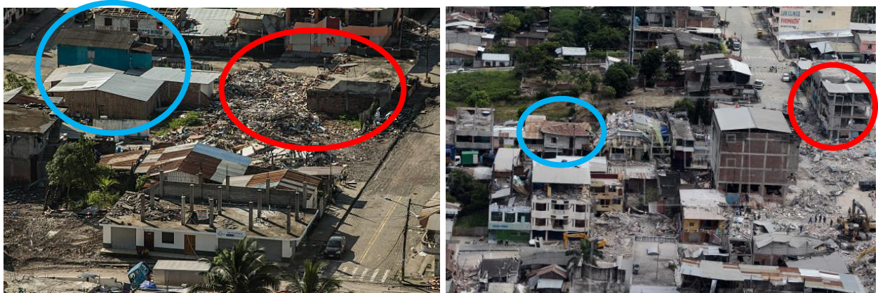
Figura 116 Resistencia de viviendas de caña vs viviendas de hormigón durante el terremoto. Fuente: (El diario manabita, 2017)
