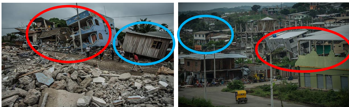
Figura 117 Demostración de ligereza de viviendas de caña vs viviendas de hormigón durante el terremoto. Fuente: (El diario manabita, 2017)
