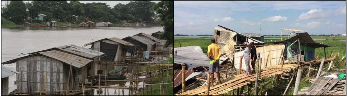
Figura 48 Desplazamientos de viviendas por efectos de licuefacción del suelo Fuente: (Web, 2021)
