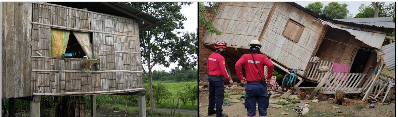
Figura 49 Mal armado de elementos estructurales en viviendas en caña Fuente: (Diario el Universo, 2021)
