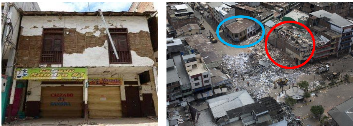
Figura 119 Demostración de daños menores de viviendas de caña vs viviendas de hormigón durante el terremoto. Fuente: (Bahía tv, 2020)
