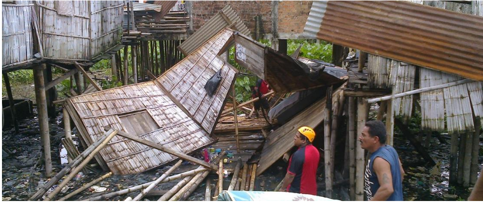
Figura 50 Separación de elementos en viviendas en caña Fuente: (El autor de esta investigación, 2021)
