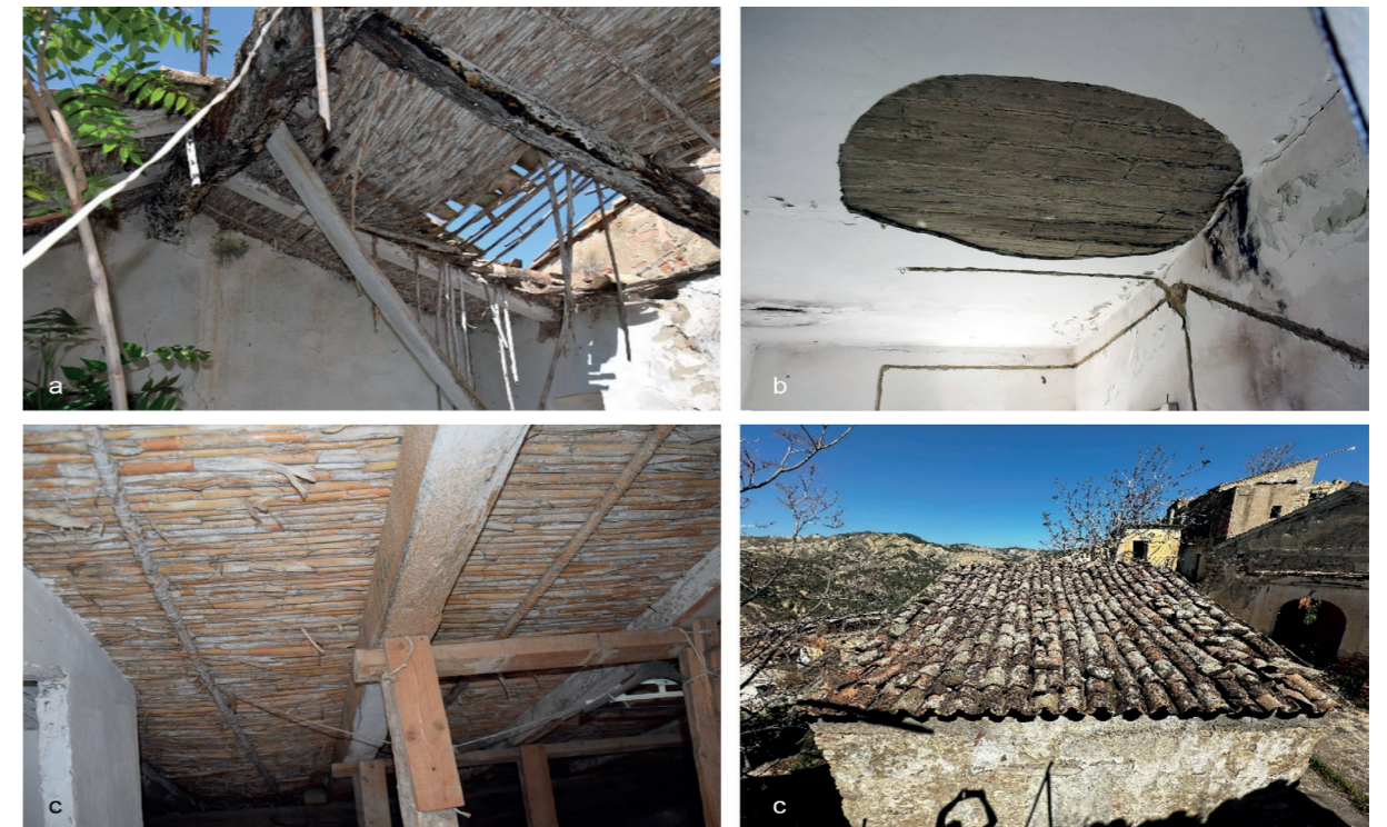
Fig. 7 - a: copertura edificio 25b travi, canne e tegole. b: Copertura edificio 25a, II piano vano in ampliamento. c: copertura edificio 25a travi canne e tegole.
