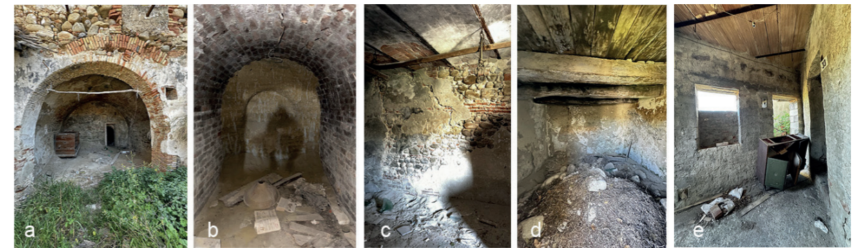
Fig. 6 - a: Volta a botte in mattoni edificio 25 b piano terra. b: Volta a botte in mattoni edificio 25a cantina piano terra. c: Solaio con putrelle e voltine (travi con soletta deformabile) edificio 25 a piano terra. d - Solaio in legno con tavolato a semplice orditura (travi con soletta deformabile) edificio 25 d piano terra. e - Solaio in putrelle e tavelloni (travi con soletta semi-rigida) edificio 25 a piano I.
