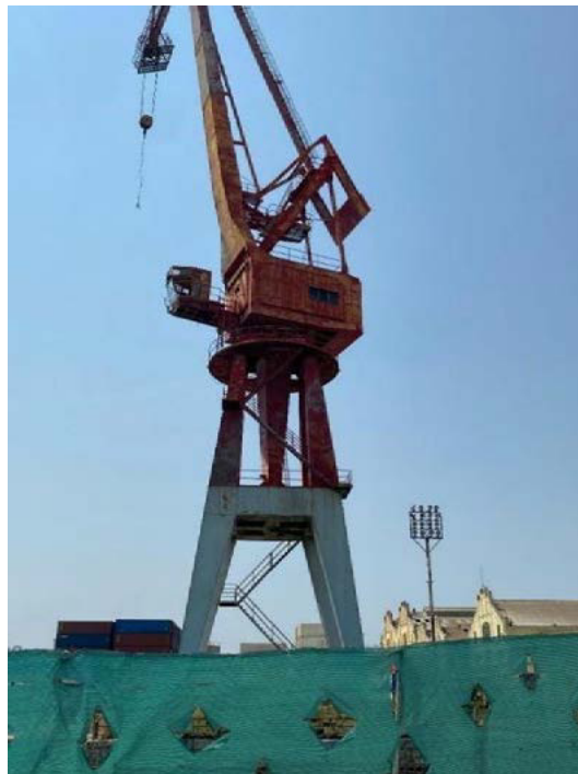
Fig. 3. Gru storica Cabría del porto di Valencia per il sollevamento e lo scarico delle merci dai magazzini portuali. Il meccanismo a carrucola e argano testimonia le tecnologie portuali dei primi decenni del XX secolo (@ autori, 2025).
