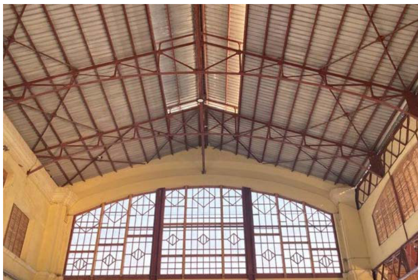
Fig. 1. Copertura con lucernaio sorretta da capriate metalliche reticolari e arcarecci e facciata in acciaio e vetro del Tinglado n. 2 del porto di Valencia (@ autori, 2025).
