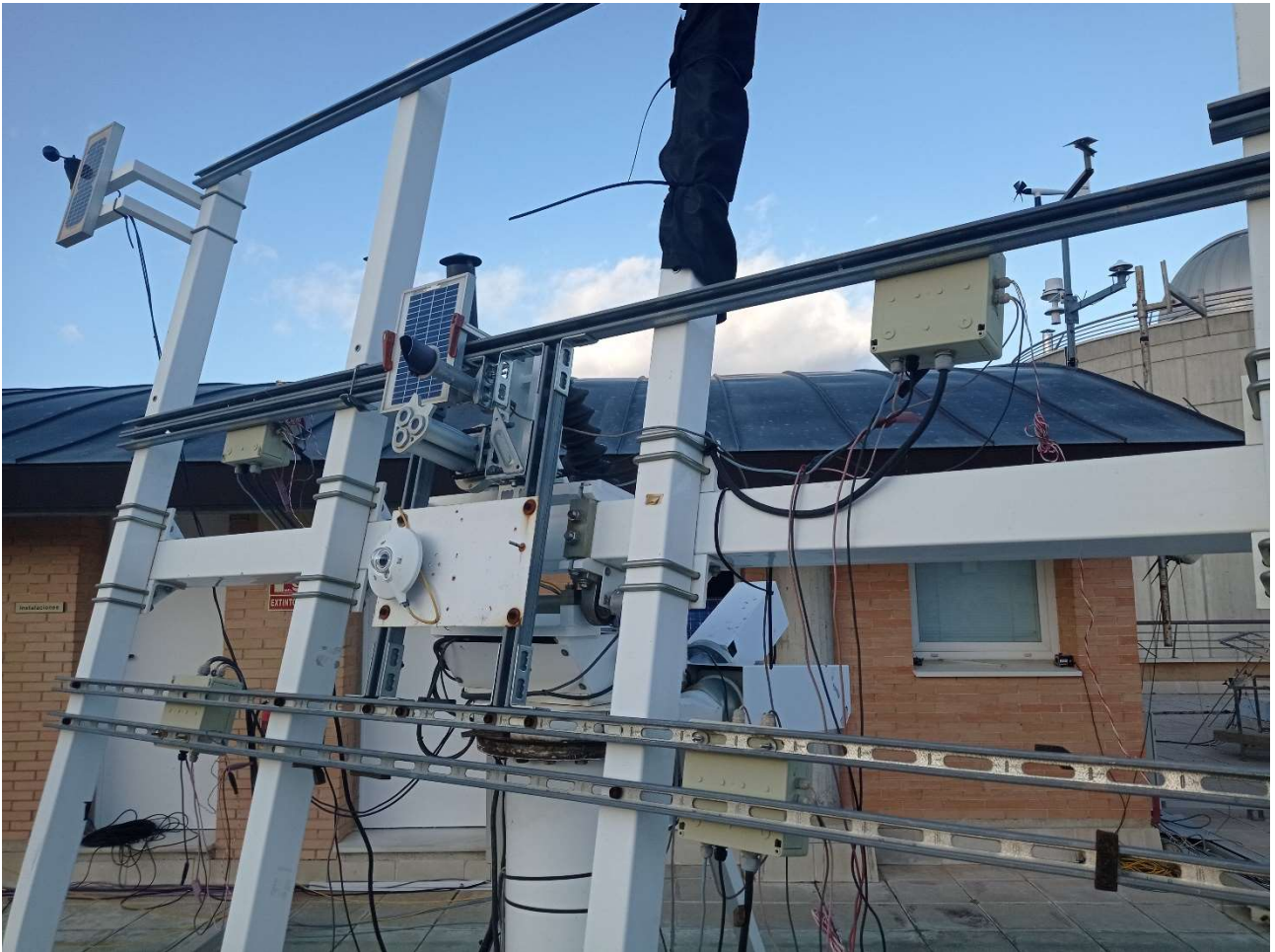
Figura 90. Sistema sperimentale situato presso l'università di Jaén, in evidenza le scatole per l'alloggiamento delle schede elettroniche di misura.
