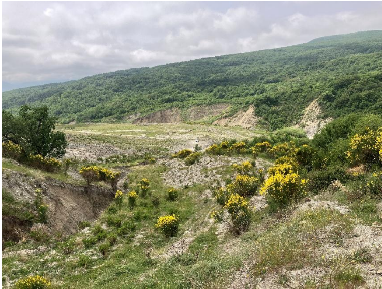
Figura 2–6 panoramica del versante destro
