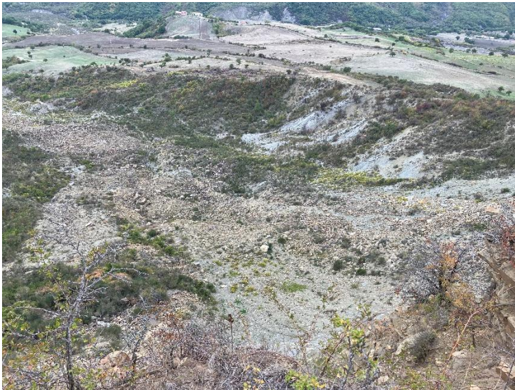
Figura 2–7 panoramica del versante sinistro
