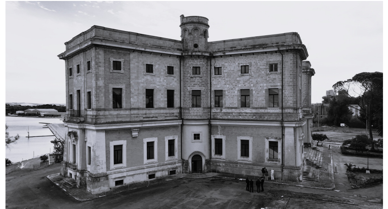
Fig. 1 - Foto palazzina del Comando di Taranto. Fonte: rilievo fotografico condotto dagli studenti dell'Università degli studi di Salerno e Università degli Studi della Basilicata.
