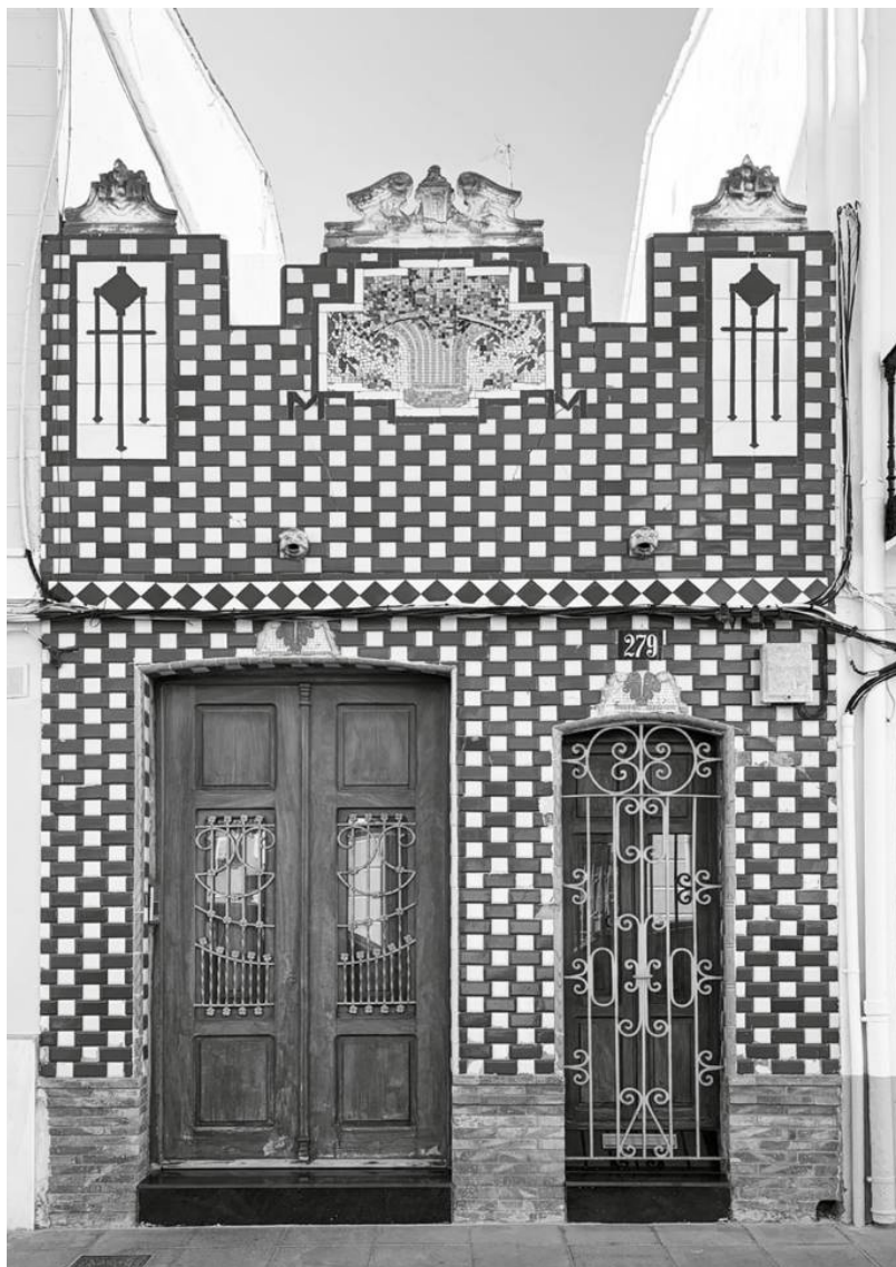
Figura 3. Fachada del Cabanyal caracterizada por la combinación de formatos y cromatismos cerámicos, representativa de la variabilidad formal asociada al reaprovechamiento material [Fuente: elaboración propia].
