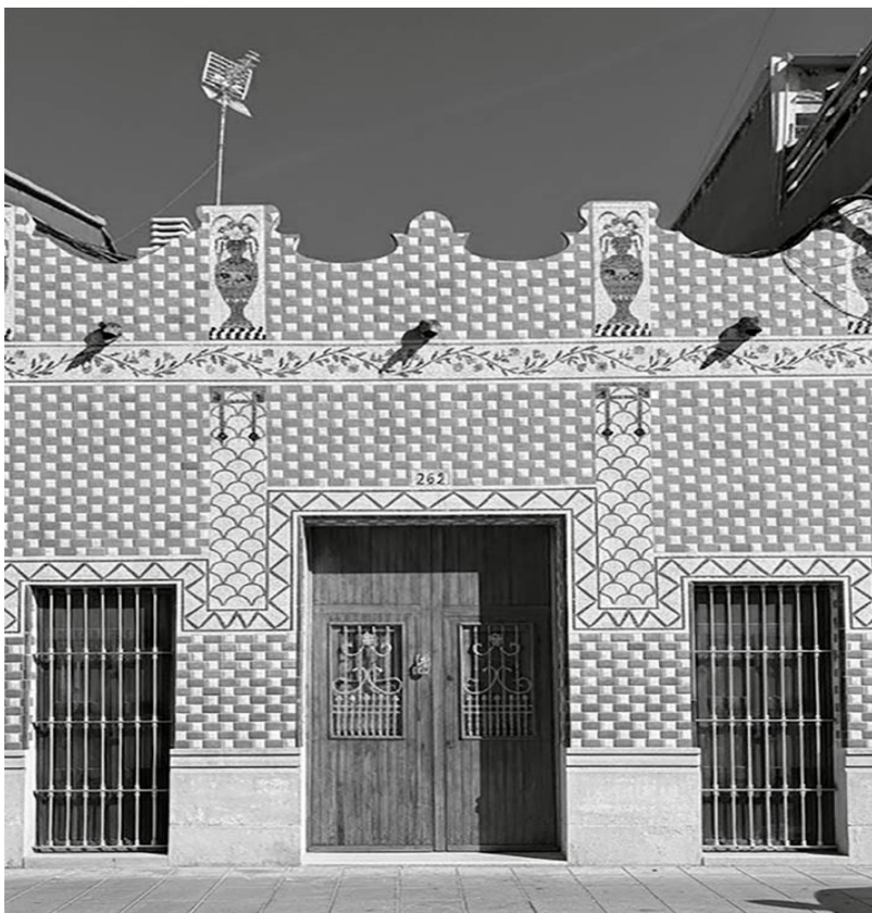
Figura 4. Fachada caracterizada por el uso de elementos decorativo tradicionales de cerámica y en relieve. [Fuente: elaboración propia].
