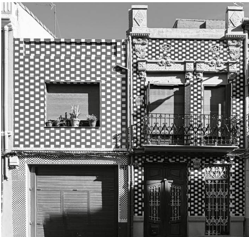
Figura 2. Fachadas decoradas con revestimiento cerámico vidriado verde y azul en relieve [Fuente: elaboración propia].
