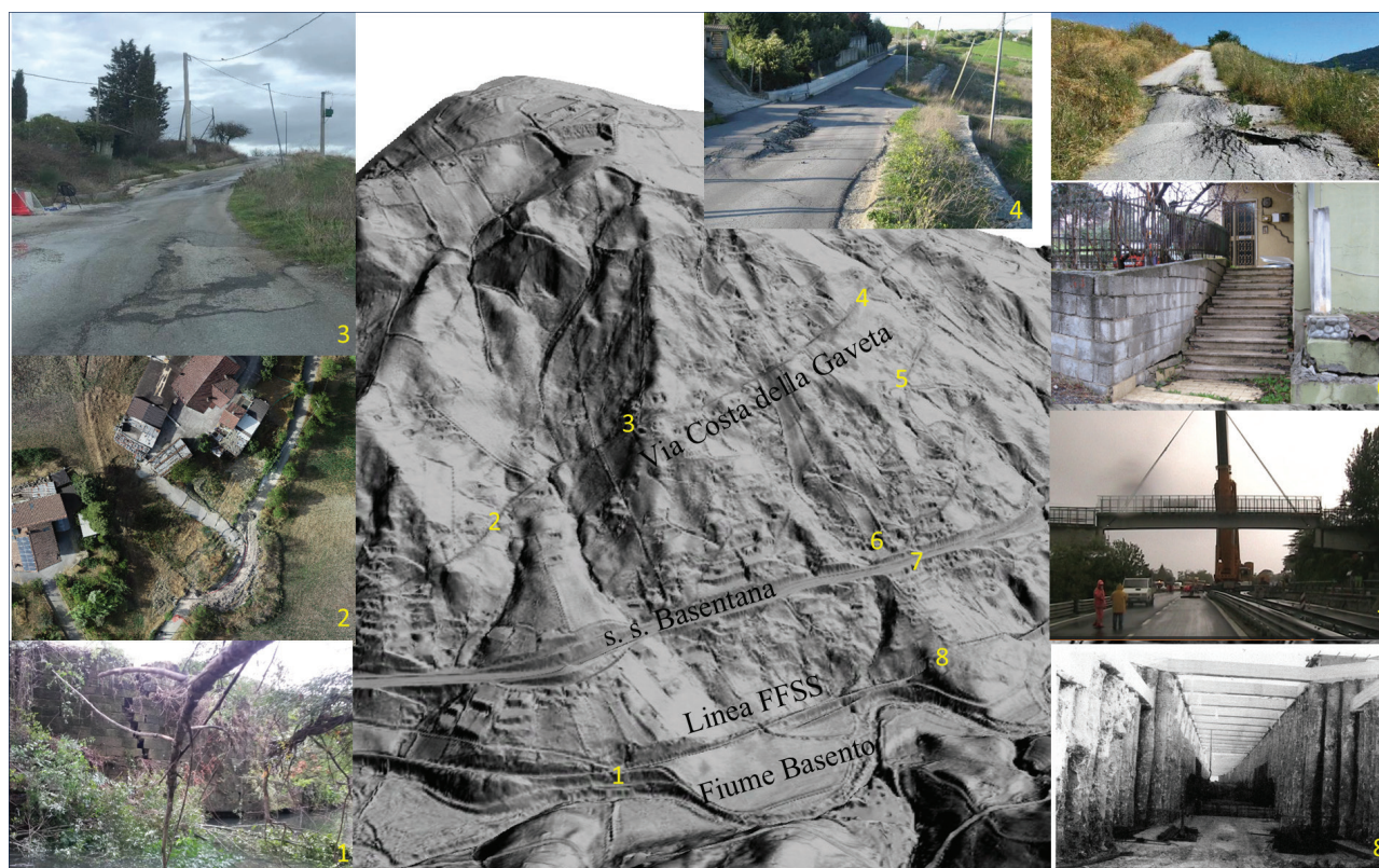
Fig. 3 – DTM del versante di Costa della Gaveta e quadro di alcuni danni provocati dalle frane a strutture ed infrastrutture.
