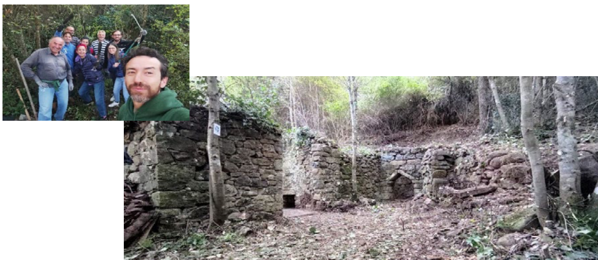
Fig. 3. Calchera a mezza costa, di forma tronco-conica, dotata di bocca di carico del combustibile (legna) delimitata da un elemento triangolare in pietra. In aderenza al manufatto si conserva un locale in muratura di pietra, a pianta rettangolare, verosimilmente destinato a deposito o ricovero degli attrezzi, oggi privo della copertura originaria, un tempo realizzata con travi lignee e manto in coppi. L'intero complesso produttivo, ubicato in un'area boscata a valle dell'antico abitato de Il Casale, nel territorio comunale di Armento (Potenza), risultava completamente occultato dalla vegetazione spontanea ed è stato riportato alla luce grazie all'attività di ricognizione condotta in collaborazione con l'associazione Armentando.
