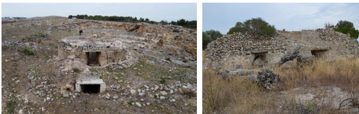
Figg 1 -2. (a sinistra) Calchera a pianta circolare fuori terra con tunnel a trincea per l'alimentazione della legna di combustione in prossimità della cava storica di calcare nell'antico distretto produttivo della Località Jesce (Altamura). (a destra) Calchera a pianta circolare fuori terra due a sud della Masseria Tirlecchia, lungo la riva destra del Fiume Bradano in località Tre Confini (Matera).
