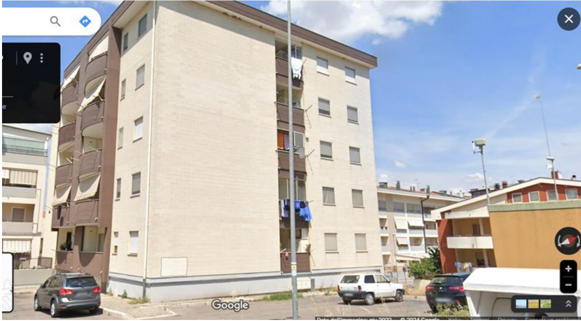
Fig. 13 Vista dell'edificio prima dell'installazione della parete verde verticale.
