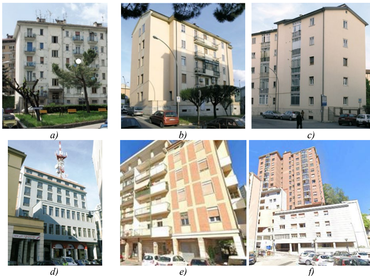
Figura 4.5 – Esempi di edifici rappresentativi delle tipologie strutturali nell'area urbana di Potenza. Per la tipologia Infill frame : complesso edilizio di Rione Libertà (a), case popolari del Rione Lucania (b) e edificio per i dipendenti del Banco di Napoli (c). Per la tipologia Pilotis frame : uffici S.E.T. (d), edificio di Parco Tre Fontane (e) e residenze universitarie di Largo della Torre Guevara (f).
