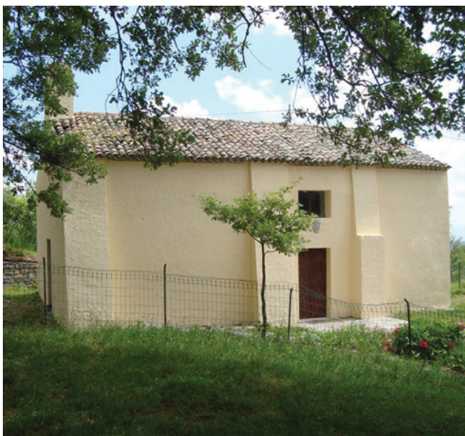
Figura 7. Il prospetto sud-ovest della chiesa di Rossano
