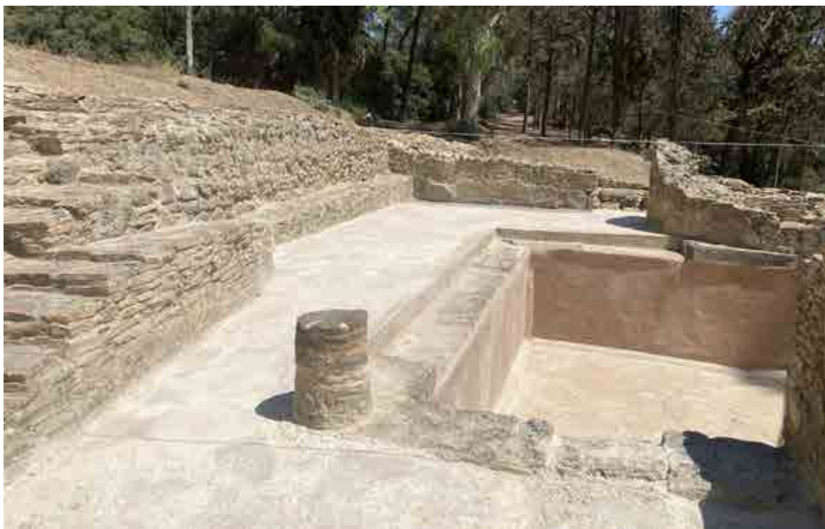
Fig. 3.2. Ambulacro a ovest della piscina (ambiente 3) dopo gli interventi di restauro. Vista da sud.
