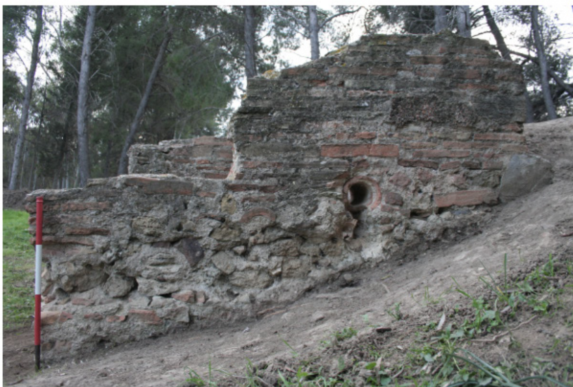
Fig. 2.61. Cisternino con vista da est (in alto) e da nord (in basso).
