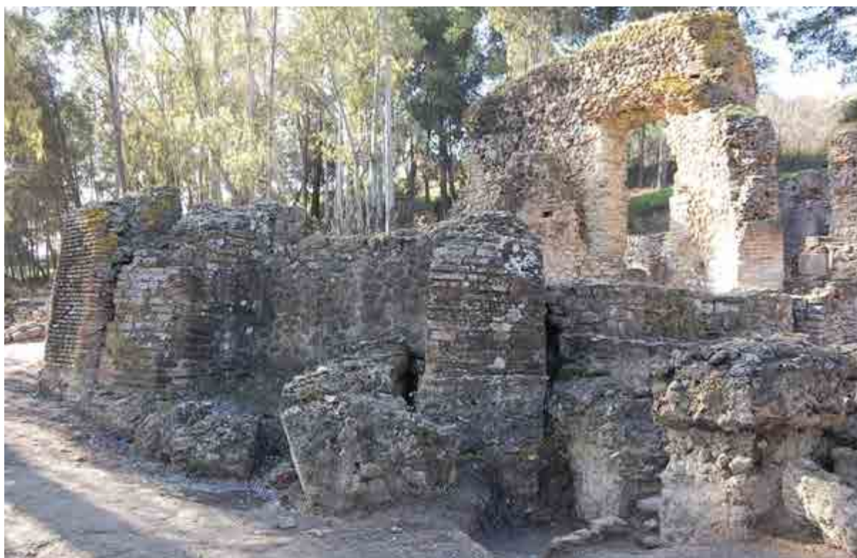
Fig. 2.45. Ambiente 9 ( laconicum - sudatorium ). Contrafforte in laterizi a sostegno della parete est.
