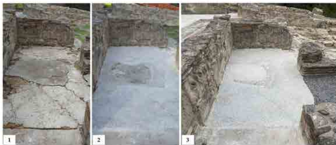
Fig. 3.3. Mosaico dell'ambiente 14 (vista da sud) prima degli interventi di restauro (1), dopo l'asportazione delle colmate cementizie (restauri precedenti) (2), dopo gli interventi di restauro (3).
