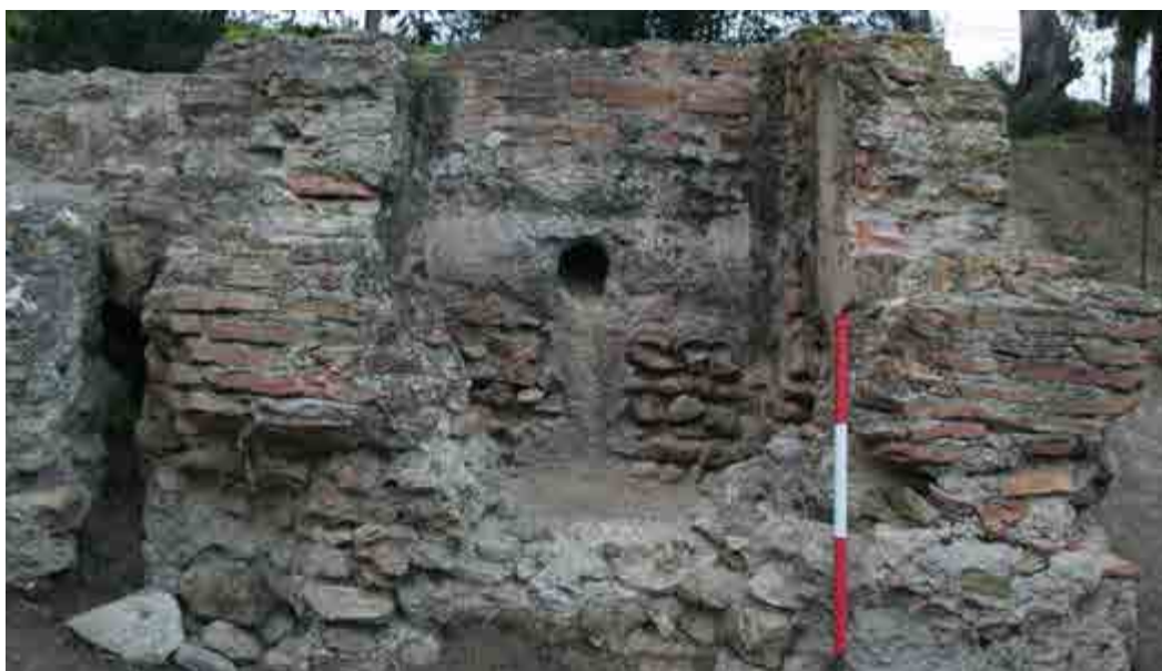
Fig. 1.8. Cisternino a ovest dell'impianto termale con vista da est.
