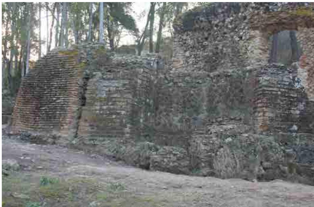
Fig. 2.4. Muro circolare con contrafforti (ambiente 9) con vista da est.
