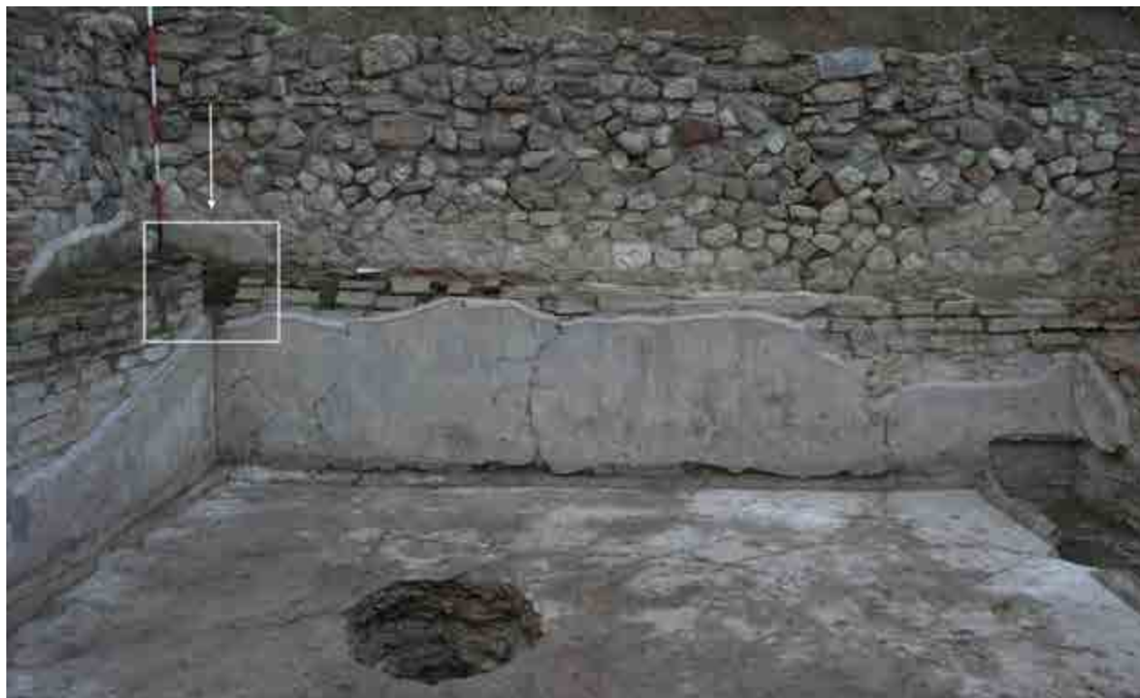
Fig. 2.36. Ambiente 5 con indicazione dell'incavo per l'alloggiamento della tubatura di afflusso idrico.
