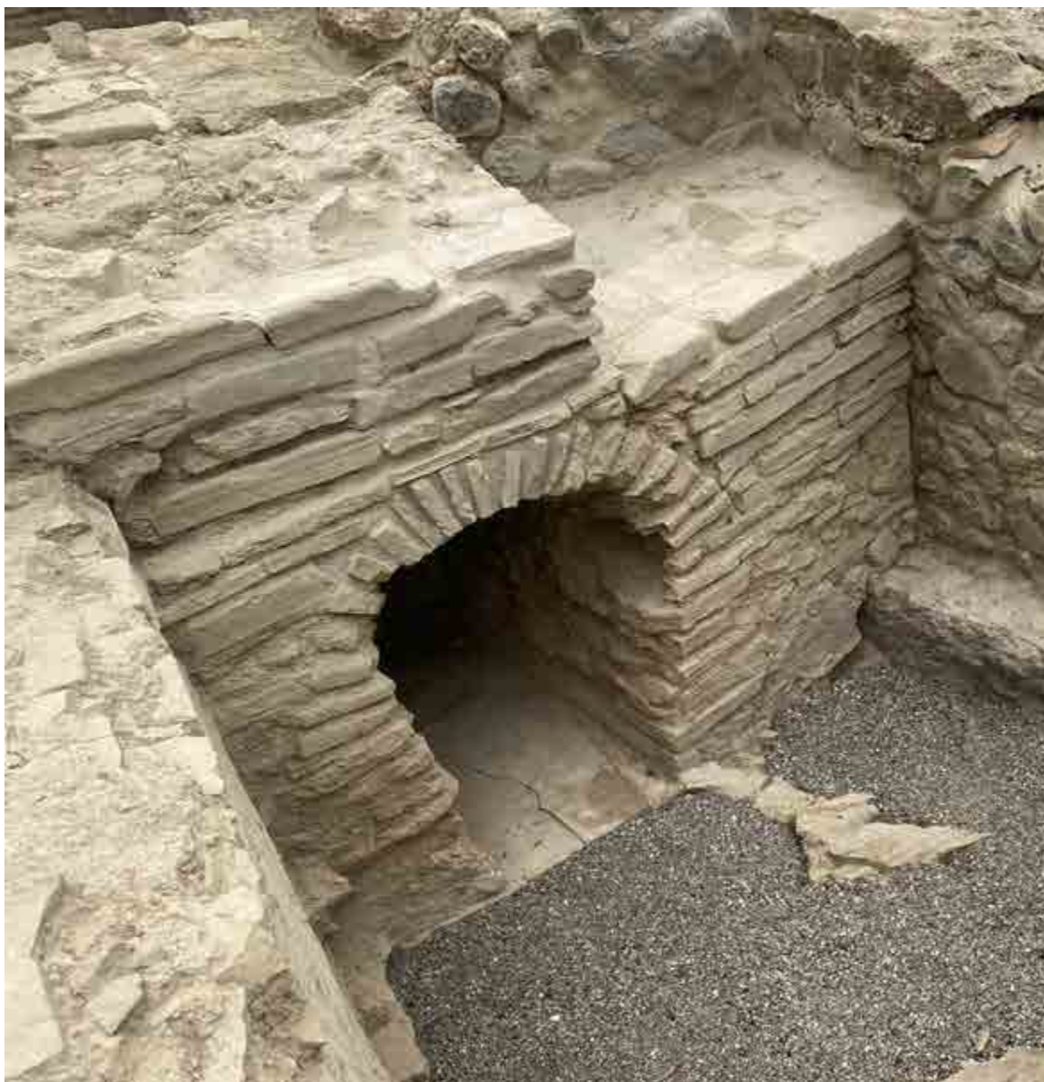
Fig. 3.1. Praefurnium (ambiente 15) dopo gli interventi di restauro (vista da sudovest).
