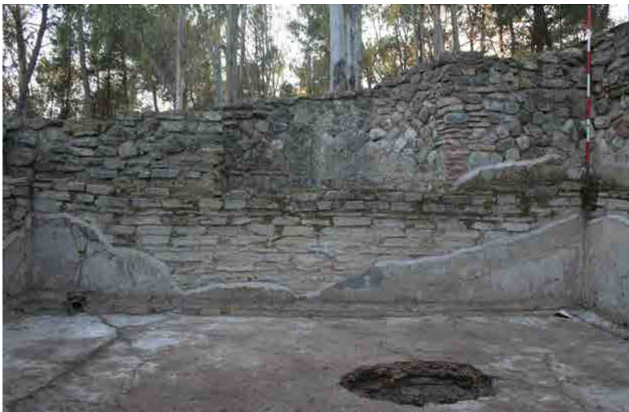
Fig. 2.35. Parete sud della vasca (ambiente 5). A sx. imbocco tubo fittile per lo svuotamento idrico.
