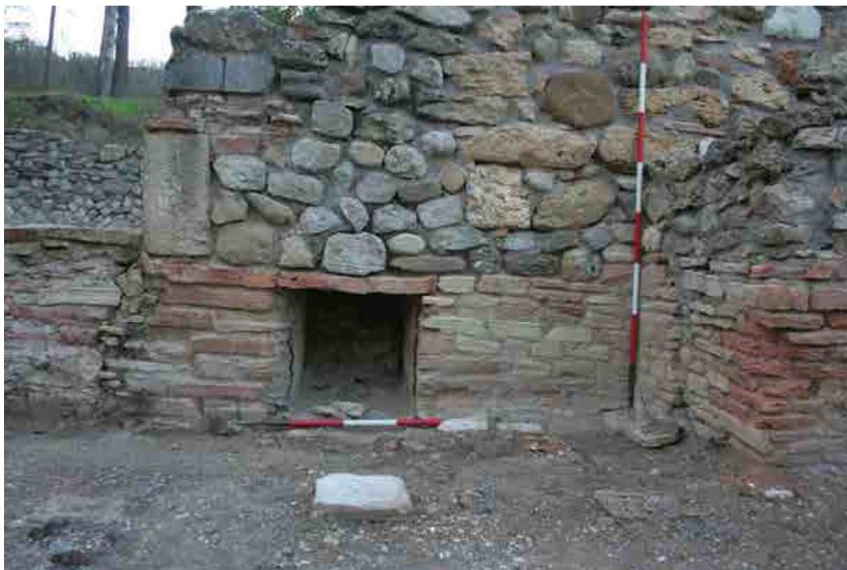
Fig. 2.38. Ambiente 6 ( calidarium ). Apertura rettangolare nord per la circolazione dell'aria calda tra gli ambienti 6 e 5. Vista da est.
