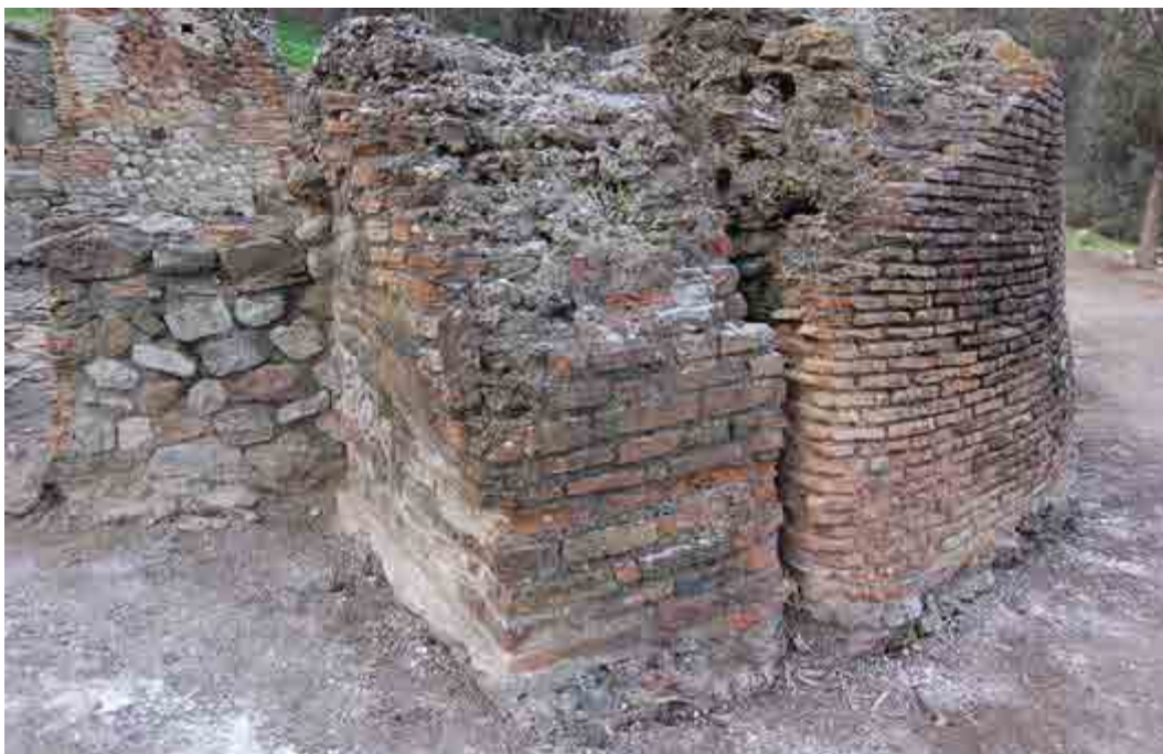
Fig. 2.6. Contrafforti esterni con vista da est.
