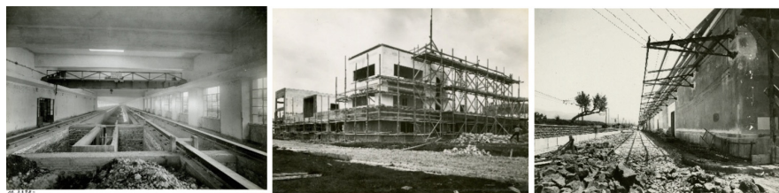
Fig. 4. On the left, internal photo of the hydrodynamic tank under construction; in the center, photos of the Wind Tunnels laboratory; on the right, Aeronautical Construction Plant with detail of the steel canopy. (fonte: Archivio Centrale dello Stato, fondo - Archivio degli organi politici e amministrativi dello Stato, fondo- direzione generale del demanio, subfondo - divisione demanio, serie - costruzione aeroporti, fotografie).
