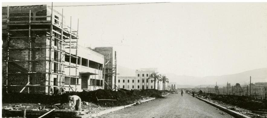
Fig. 3. Photo of the main avenue of the D.S.S.E. Construction Site. (fonte: Archivio Centrale dello Stato- Fondo - Archivio degli organi politici e amministrativi dello Stato, fondo- direzione generale del demanio, subfondo - divisione demanio, serie - costruzione aeroporti, fotografie).
