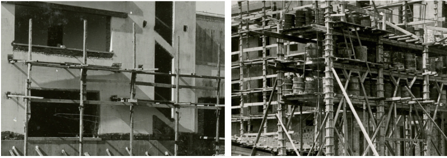
Fig. 7. Detail of the service scaffolding and the connections between them (fonte: Archivio Centrale dello Stato- Fondo - Archivio degli organi politici e amministrativi dello Stato, fondo-direzione generale del demanio, subfondo - divisione demanio, serie - costruzione aeroporti, fotografie).
