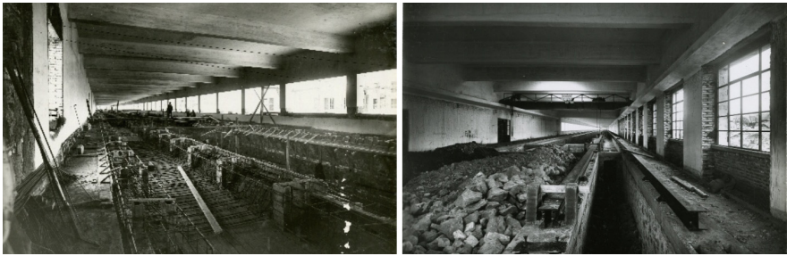
Fig. 10. Interior views of the hydrodynamic tank under construction (fonte: Archivio Centrale dello Stato- Fondo - Archivio degli organi politici e amministrativi dello Stato, fondo- direzione generale del demanio, subfondo - divisione demanio, serie - costruzione aeroporti, fotografie.).
