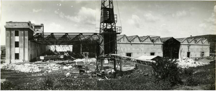
Fig. 15. External overview of the construction phase of the Aeronautical Construction Plant (fonte: Archivio Centrale dello Stato- Fondo - Archivio degli organi politici e amministrativi dello Stato, fondo- direzione generale del demanio, subfondo - divisione demanio, serie - costruzione aeroporti, fotografie).
