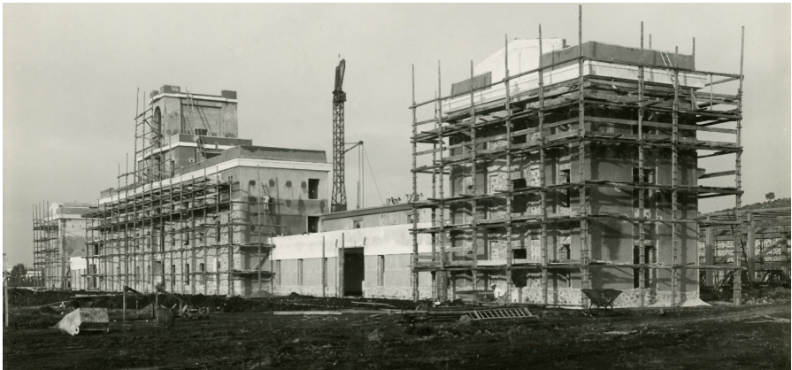
Fig. 5. Photo of the façade of the Aeronautical Construction Plant under construction. (fonte: Archivio Centrale dello Stato- Fondo - Archivio degli organi politici e amministrativi dello Stato, fondo- direzione generale del demanio, subfondo - divisione demanio, serie - costruzione aeroporti, fotografie).
