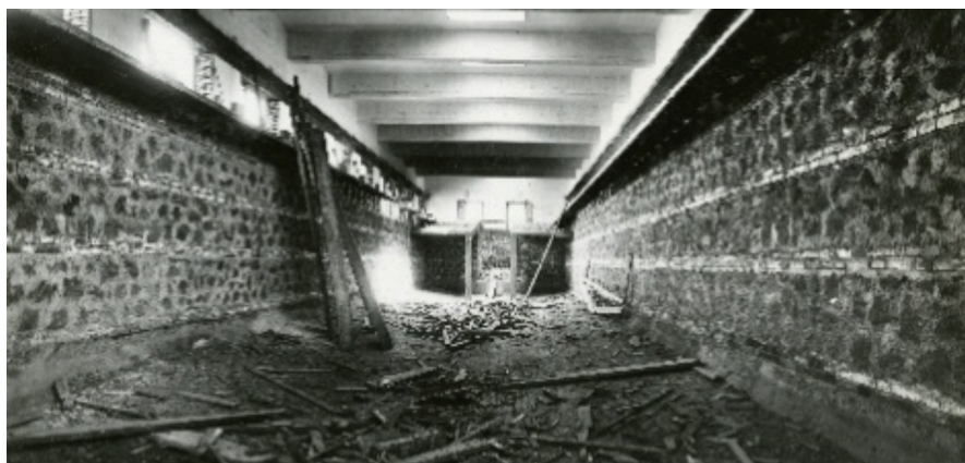
Fig. 9. Interior views of the hydrodynamic tank under construction (fonte: Archivio Centrale dello Stato- Fondo - Archivio degli organi politici e amministrativi dello Stato, fondo- direzione generale del demanio, subfondo - divisione demanio, serie - costruzione aeroporti, fotografie.).
