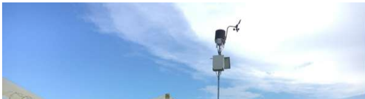
Fig. 2 Stazione meteo installata nel sito sperimentale.
