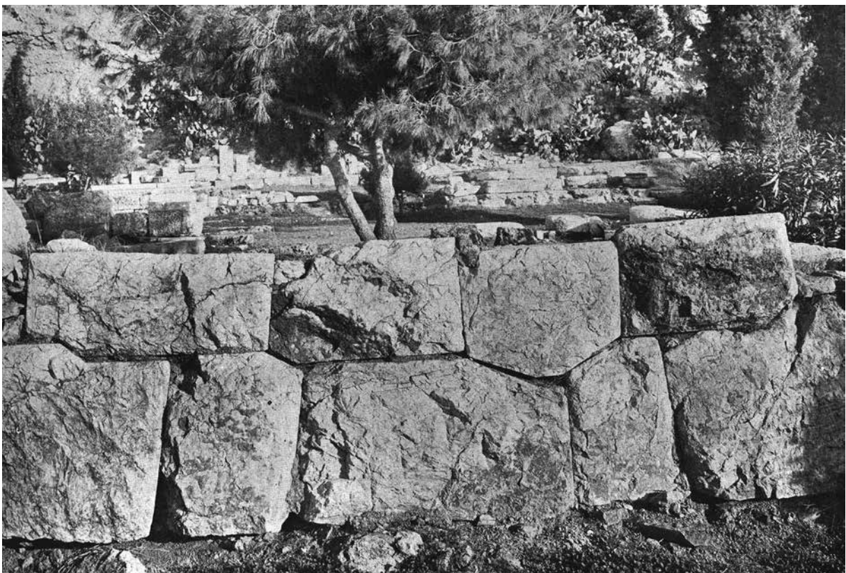
Fig. 27 - Tratto del muro cd. Pelargikon (da Wrede 1933)
