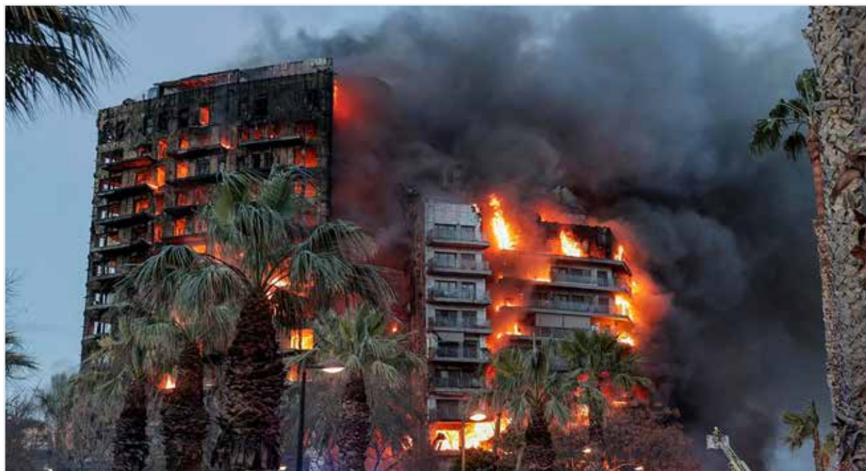
Figura 1 - Esempio di propagazione incendio in facciata (Valencia, 2024).
