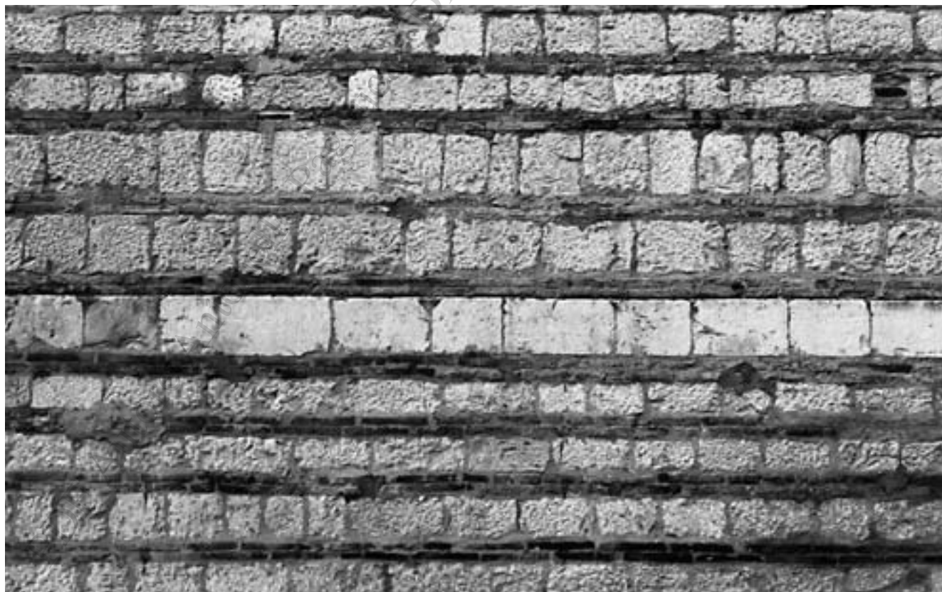
Particolare sistema costruttivo della tessitura muraria esterna
