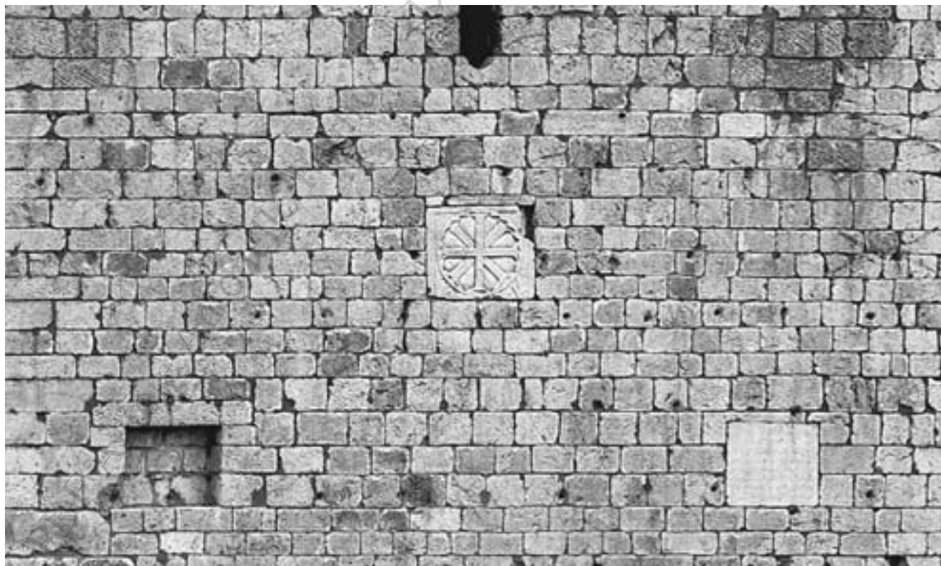
Particolare apparecchiatura muraria del campanile
