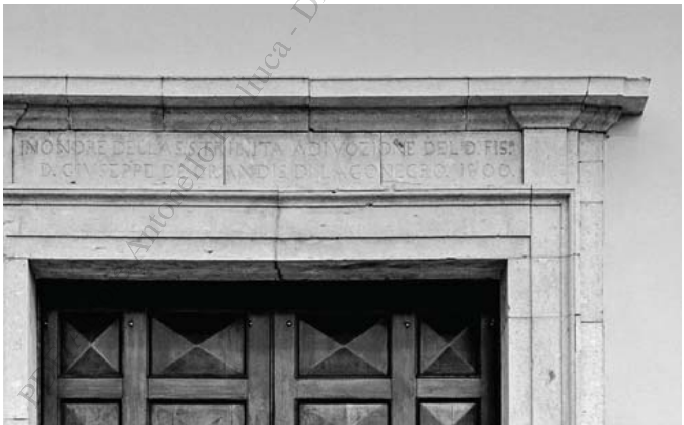
Particolare sistema costruttivo degli elementi lapidei del portale principale
