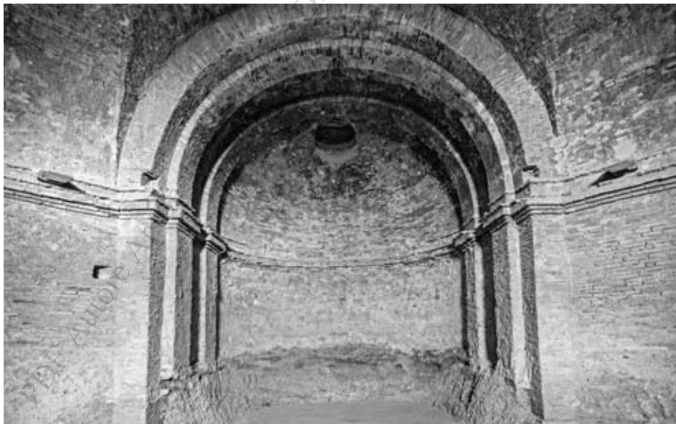
Particolare sistema di archi della Cripta
