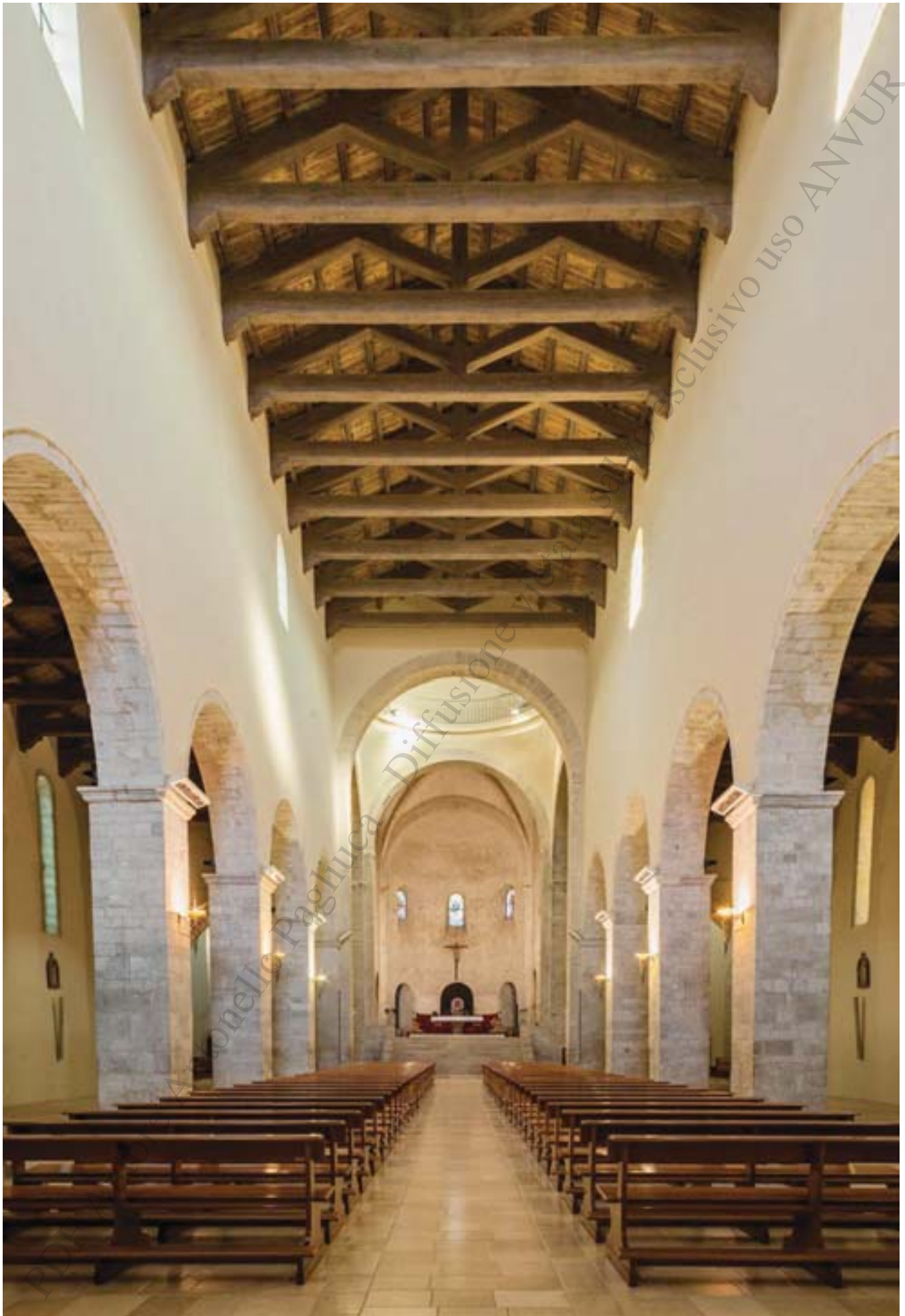
5_ Vista interna verso l'altare maggiore
