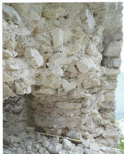
Figura 3 – Analisi in situ di una sezione muraria
