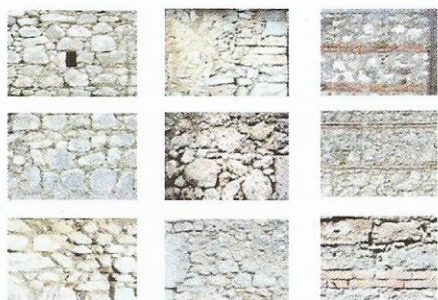
Figura 2 – Tipologie murarie: murature omogenee (prima colonna), murature disomogenee (seconda colonna) e murature listate (terza colonna)
